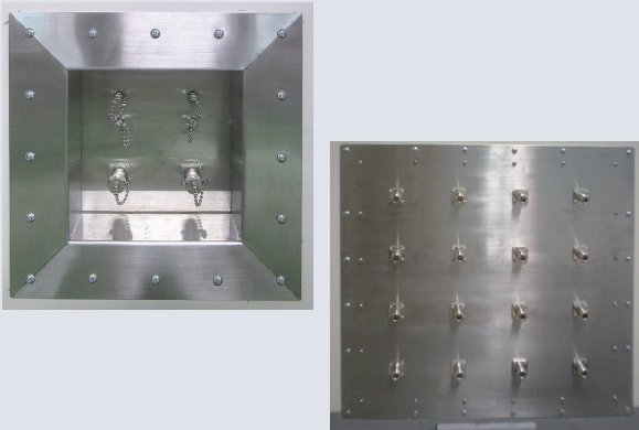
信号パネル貫通部シールド工事
