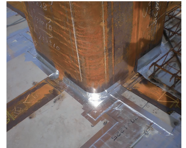
柱・梁デッキプレート シールド施工
