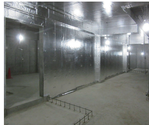
壁・天井 シールド工事①
