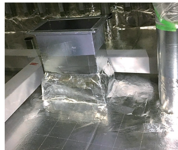
空調ダクト貫通部 シールド処理
