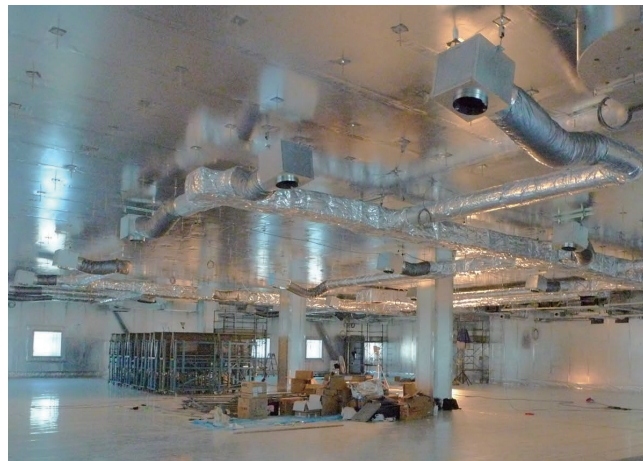
アルミシートの施工例
