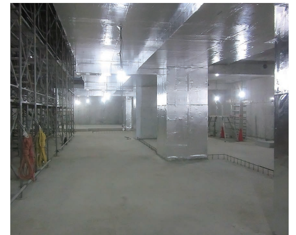
壁・天井 シールド工事②
