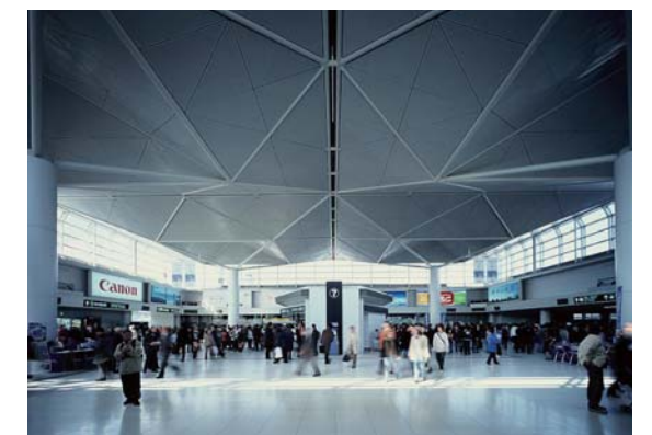
吸音パネル工事 (愛知)
