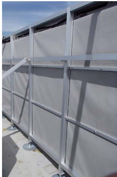
▲施工例(アルミフレーム固定)
