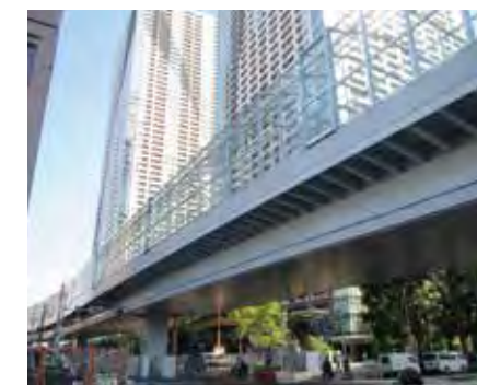
都道勝どき高架橋 (G-SP)
