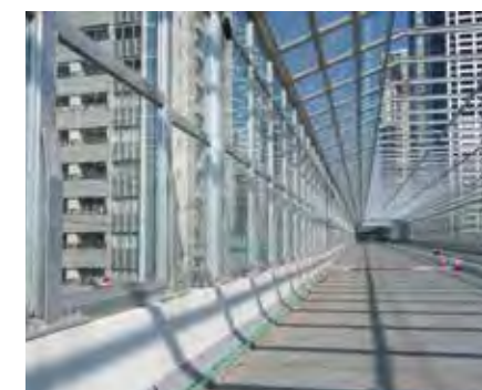
都道勝どき高架橋2 (G-SP)
