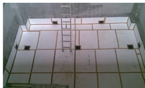
機械式駐車場 防振ゴム併用事例
