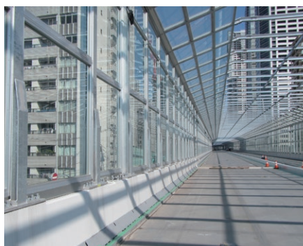
都道勝どき高架橋2 (G-SP)
