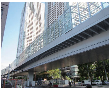
都道勝どき高架橋 (G-SP)
