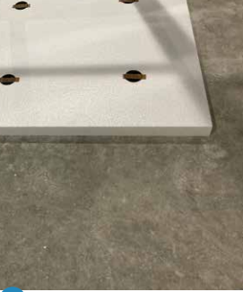
1 発泡材+防振材敷き
