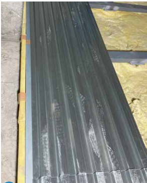
4 グラスウール敷→キーストンプレート敷
