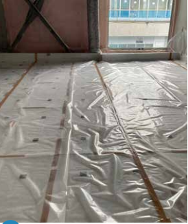
2 ポリフィルム養生
