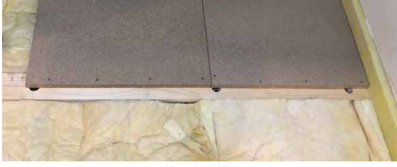
乾式(パーティクルボード)施工状況
